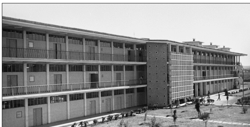
Здание политехнического института в г. Бахр-Дар, построенное при поддержке СССР. Эфиопия, 1969 г. Фото РИА Новости.
